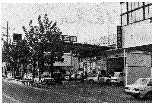
第一号の岐阜市城南通りの城南給油所
