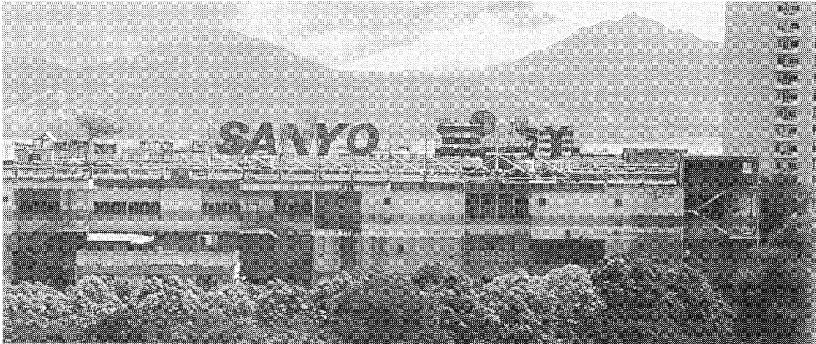
視察した三洋電機の蛇口工場
