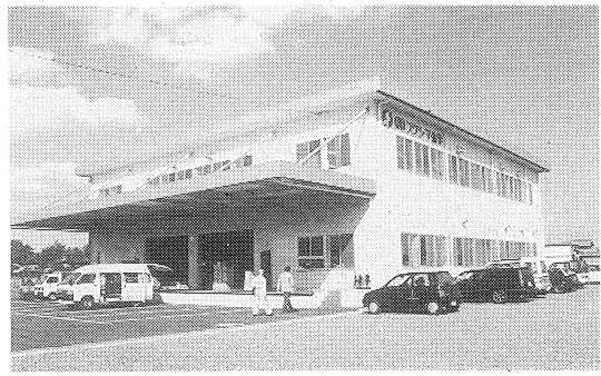
自動倉庫のある第二工場
