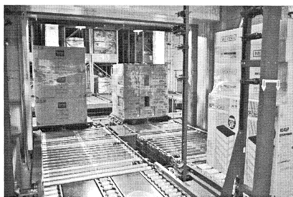
完成した商品は次々と自動倉庫へ入る
