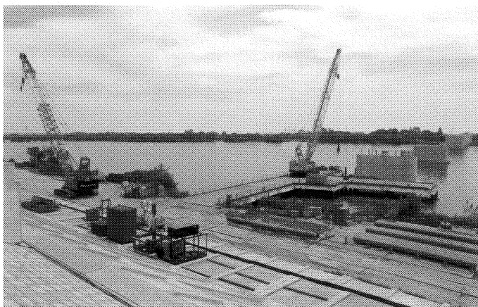
羽島市側から見た木曾川の新濃尾大橋建設工事
